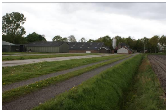
Foto-impressie van het plangebied. Boven vooraanzicht inclusief te handhaven woonhuizen, midden te slopen bebouwing en onder achteraanzicht van bestaande erven ( 7 mei 2019).
