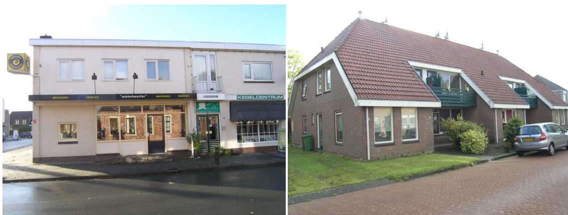
Impressie van het projectgebied op 24 september 2018 (links enkele bedrijfspanden en rechts het huizenblok)
