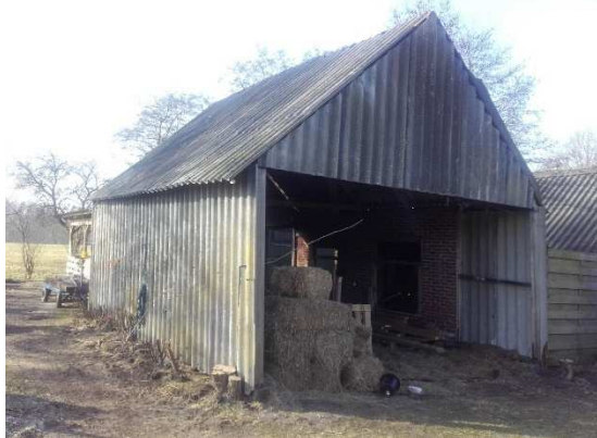
Bijgebouw 1; hooisluur oppervlakte ca. 28 m 2 voorzien van asbest dakplaten en wandplaten:
