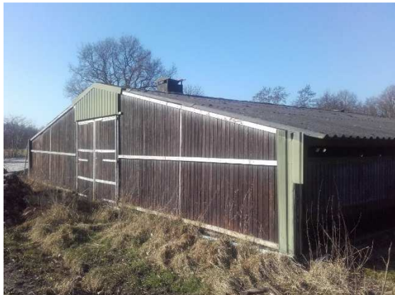
Bijgebouw 1; hooisluur oppervlakte ca. 28 m 2 voorzien van asbest dakplaten en wandplaten:
