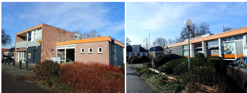
Foto 2 Een impressie van het te slopen pand, waar nieuwbouw voor in de plaats komt.
