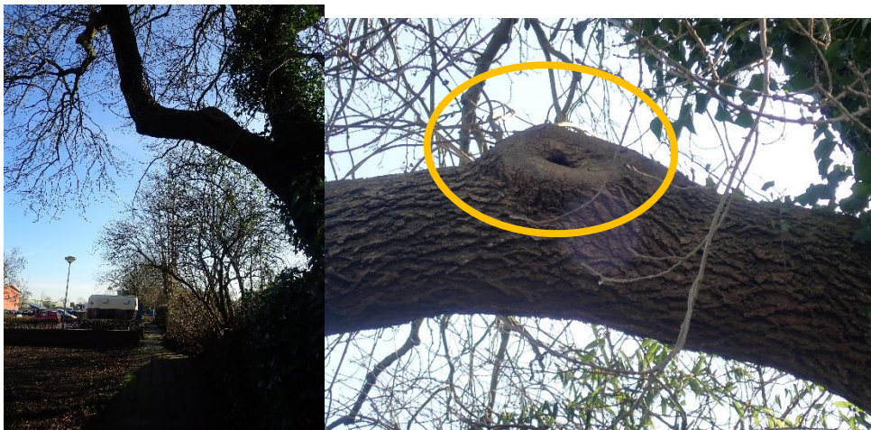
Foto 8 Een van de bomen in het plangebied heeft een holte waar mogelijk boombewonende vleermuizen een geschikte plek vinden als verblijfplaats.
