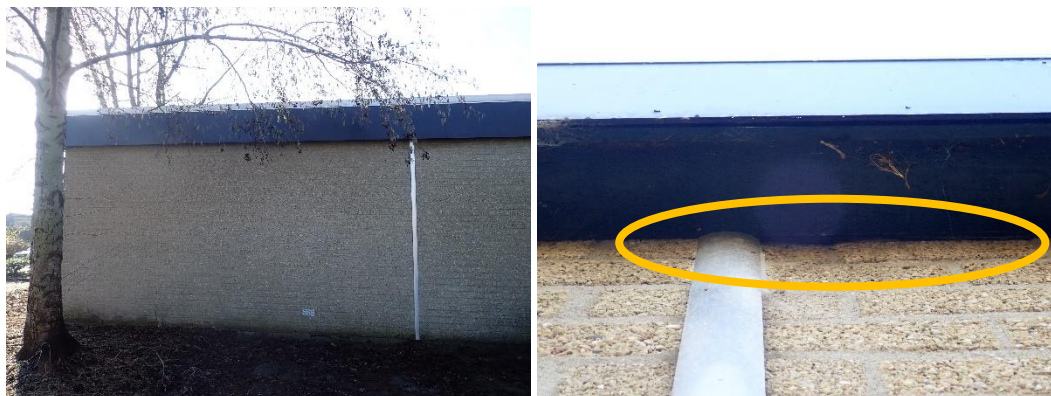
Foto 5 Een van de kieren die achter de daklijst van voormalige bibliotheek aanwezig is waar vleermuizen achter kunnen kruipen.
