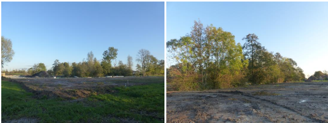
Foto 3 Het perceel bij de Brimeulaan. Op het perceel was reeds modder en zand gestort en de riolering aangelegd (links). Op het perceel is de sloot met begroeiing nog aanwezig (rechts).
