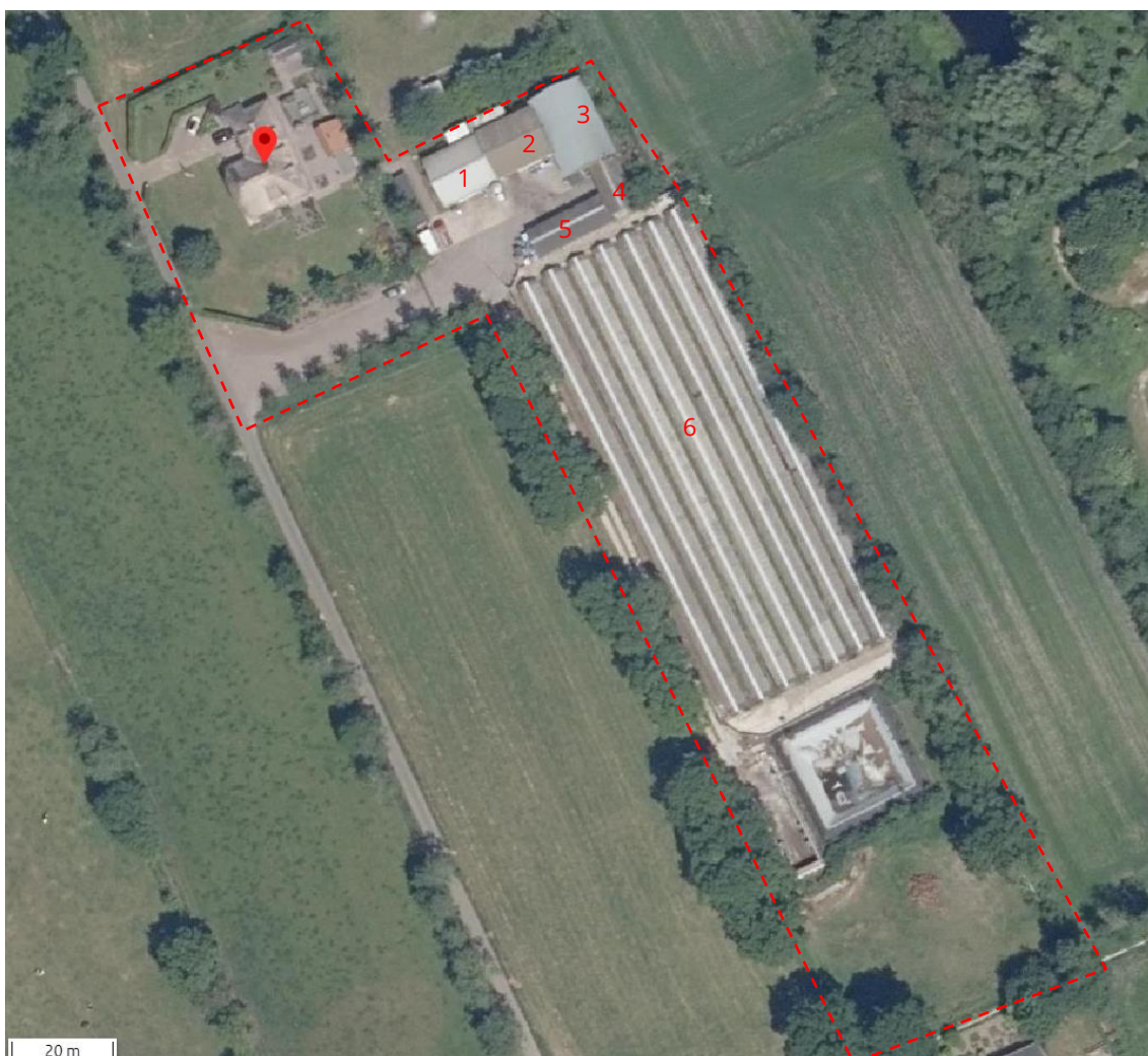
Figuur 1. Locatie van het plangebied met rode pin bij het woonhuis. Nummer 1 t/m 4 zijn schuren. Nummer 5 is een kap-schuur. Nummer 6 zijn de overkappingen met pelsdierkooien. Bron kaartondergrond: www.ruimtelijkeplannen.nl
