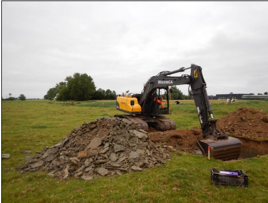
Afbeelding 4. Start aanleg werkput 1, gefotografeerd richting het noordoosten
