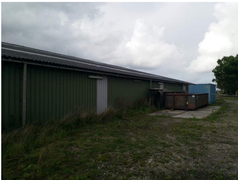
Oostgevel Willem Steeman manege, met containers voor organisch afval. Foto: M. de Vries | Ecoresult B.V.
