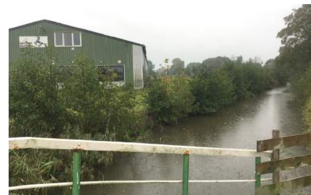
gelegen aan karakteristieke waterloop De Potmaar
