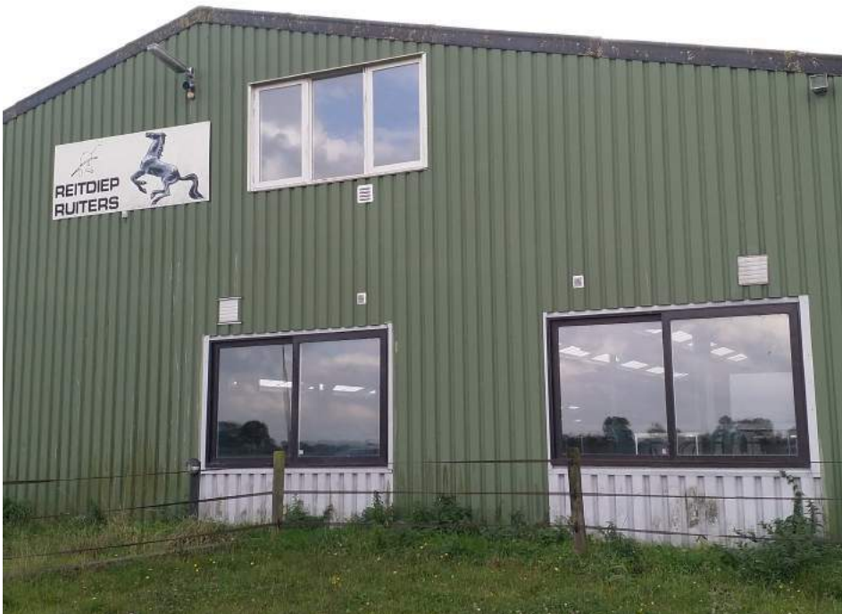
Afbeelding 7: De voorgevel opgetrokken uit golfplaten en door de ramen is te zien dat het dak uit enkel golfplaten bestaat. Foto: M. de Vries | Ecoresult B.V.
