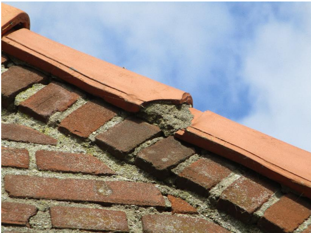
Figuur 19 De kantpannen zijn dicht gespecied en daardoor niet toegankelijk voor vleermuizen.
