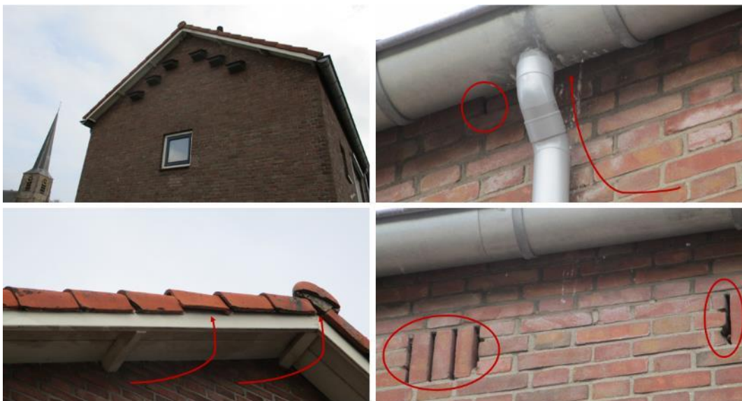
Figuur 25 Voorbeelden van potentiële inligegopeningen voor gierzwaluwen en vleermuizen in de rijtjeswoningen. Tevens wijzen de krijtsporen tegen de gevel op aanwezigheid van een (oud) gierzwaluw nest en is de onderste rij dakpannen ontoegankelijk voor huismussen door de aanwezigheid van vogelschroot.
