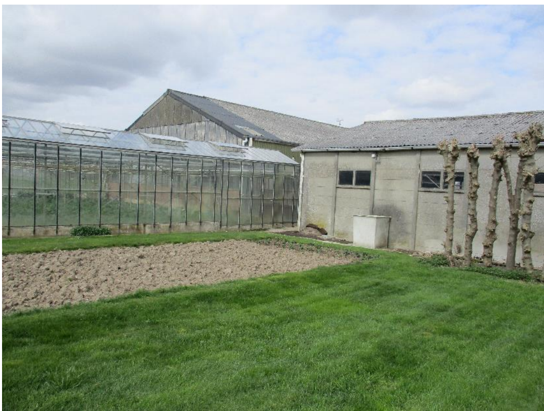
Figuur 16 Op de planlocatie zijn vier schuren en één kas gesitueerd, welke in de beoogde ontwikkelingen worden gesaneerd.
