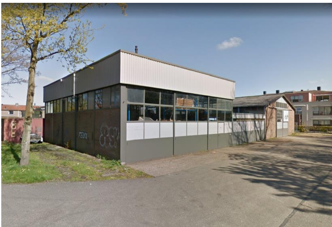
Figuur 9 De loodsen aan de Prins Bernhardlaan 6-8 te Puttershoek bezitten 1 bouwlaag.
