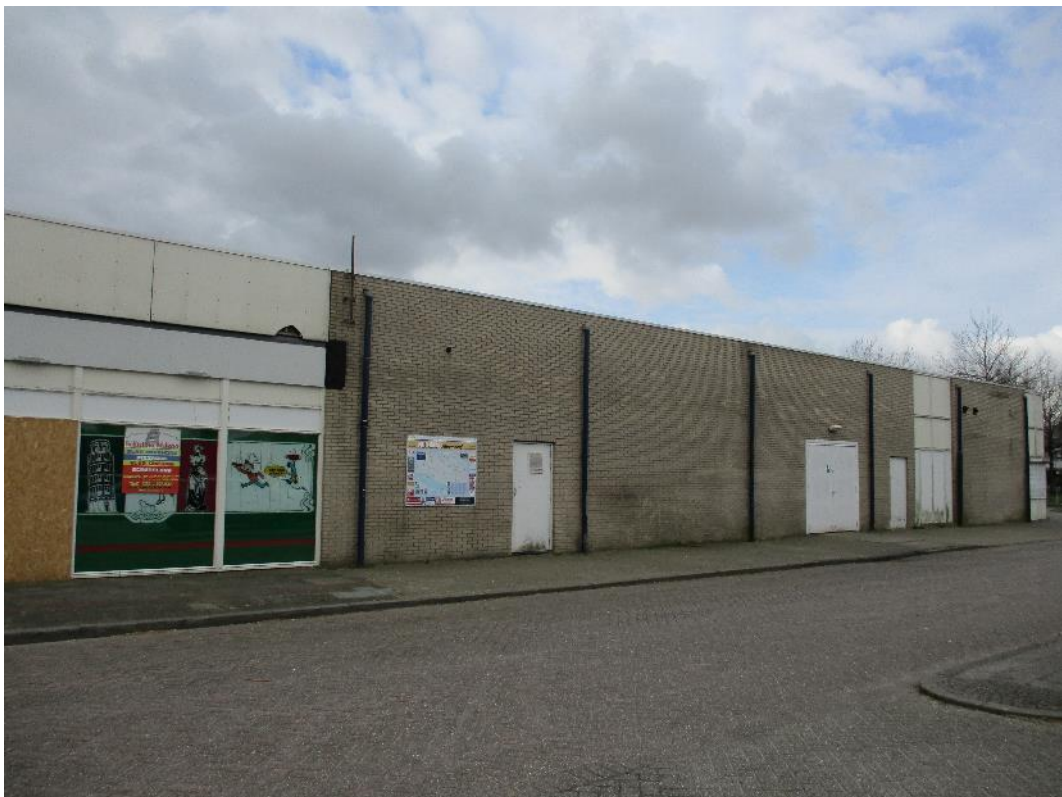
Figuur 5 De bebouwing bestaat uit één bouwlaag en bezit een plat bitumen dak.
