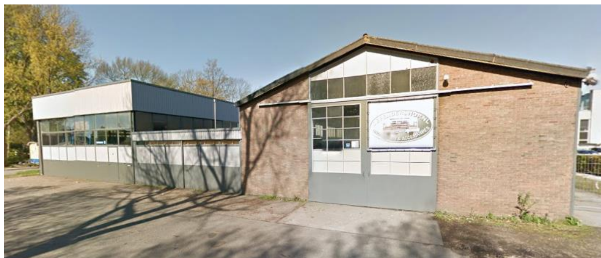
Figuur 1.2: foto bedrijfsbebouwing Prins Bernhardlaan 6-8
