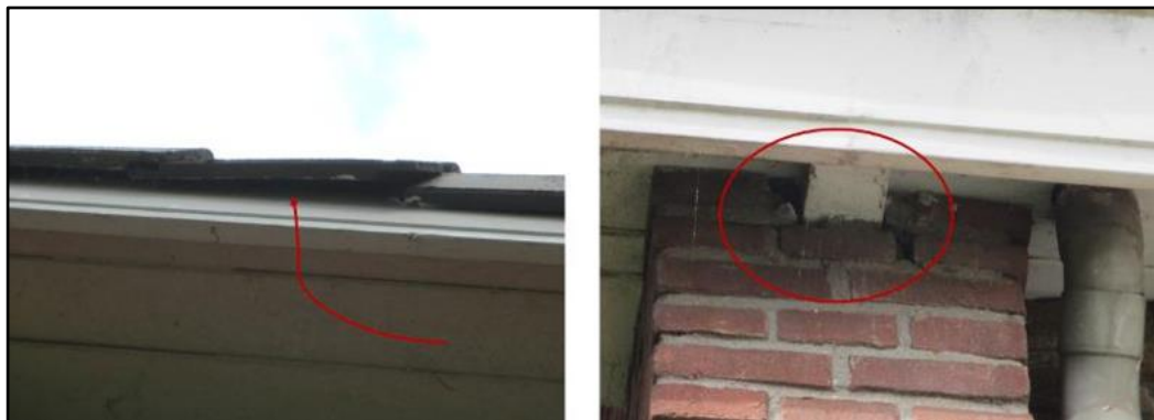
Figuur 1.3 Middels toegankelijke dakgoten, kierende kantpannen en open stootvoegen kunnen huismussen, gierzwaluwen en vleermuizen toegang krijgen tot potentiële nesten en verblijfplaatsen in de bebouwing.
