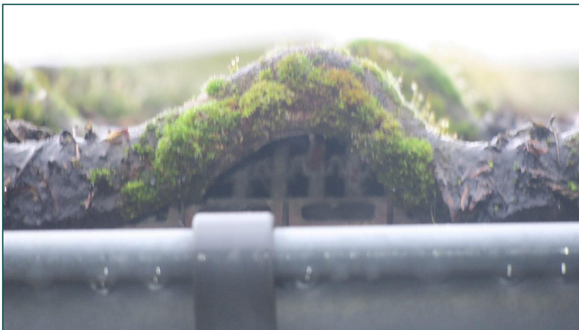
Figuur 3 Onder de dakpannen van de garage is vogelschroot aangebracht. Hierdoor zijn er geen huismus/gierzwaluw nestlocaties aanwezig op de planlocaties.
