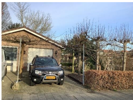
Foto 1: ingang via garage (zuiden)
