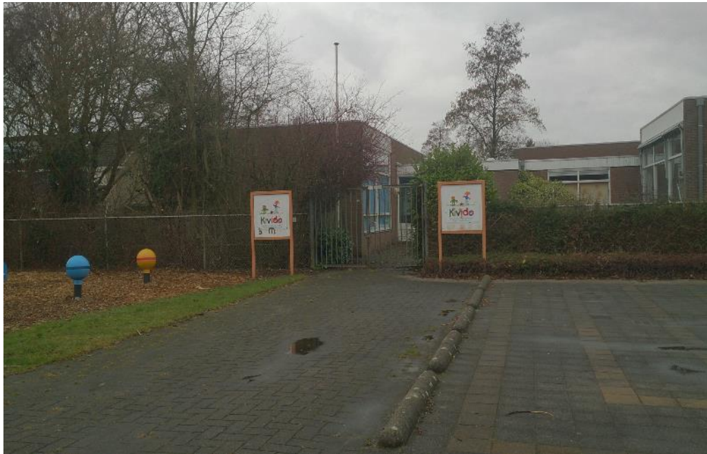
Figuur 1 De planlocatie betreft twee voormalige schoolgebouwen aan de Jan Tooropstraat te Oud-Beijerland. Beide gebouwen zijn opgetrokken uit gemetselde muren en bitumen daken.
