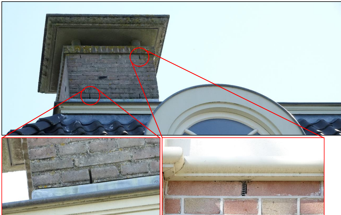
Figuur 7 open en dichte stootvoegen
