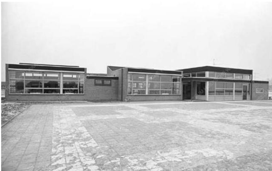
Figuur 3 School De Brug in Maasdam uit 1976, ontwerp T.C. Bos
