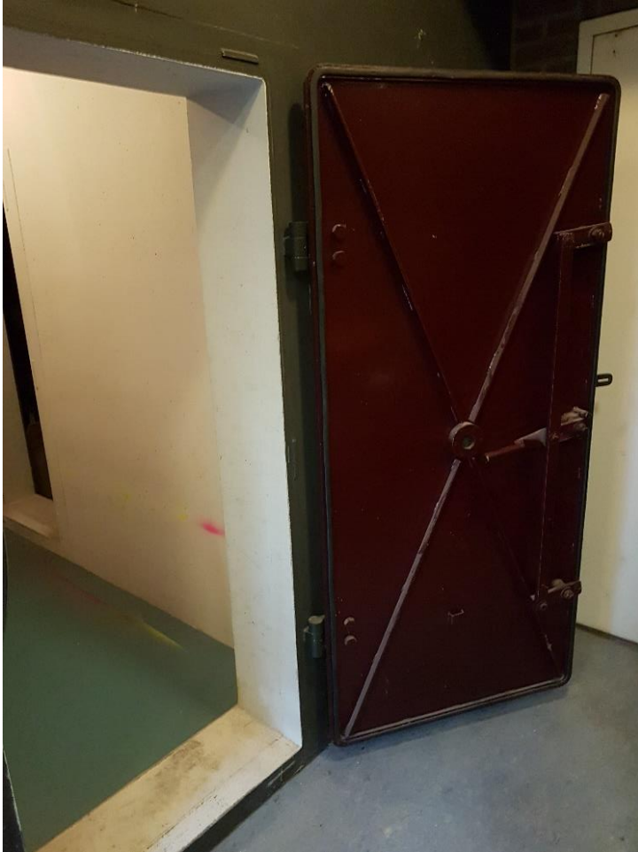
Figuur 17 Entree atoomkelder met stalen deur
