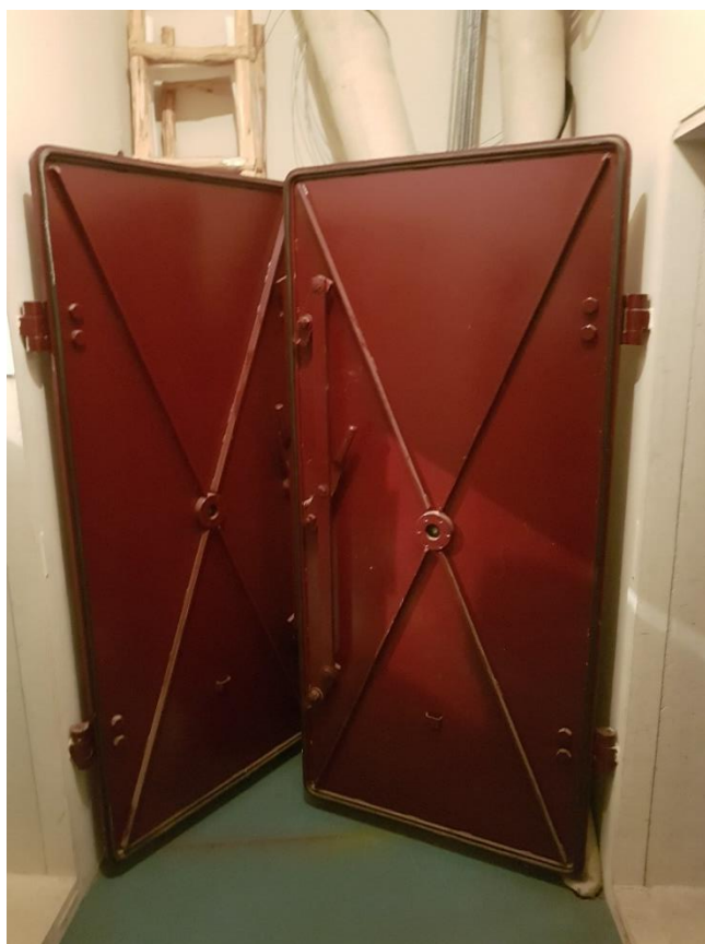
Figuur 20 Twee stalen deuren in de atoomkelder.
