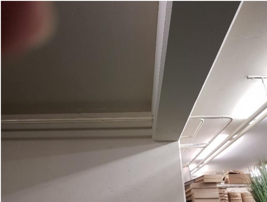
Figuur 18 Leidingen door de betonnen constructie geboord in de voormalige noodbestuurderspost.
