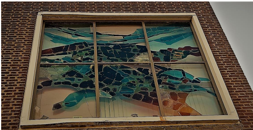
Figuur 13 Venster met glaskunstwerk buitenzijde.
