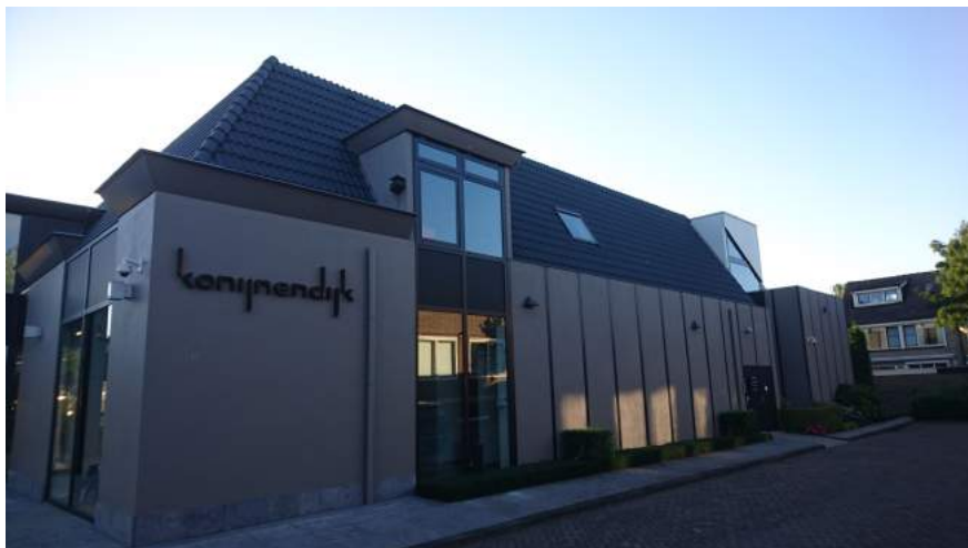
Het pannendak biedt mogelijkheden voor verblijfplaatsen van huismus. Foto: Ecoresult B.V.
