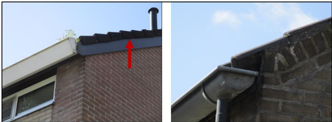
Figuur 2.50 Links: mogelijke openingen die gebruikt kunnen worden door gierzwaluwen en vleermuizen. Rechts: de dakruimte is toegankelijk voor huismussen.
