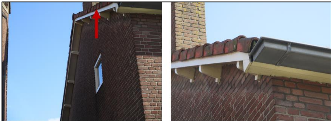
Figuur 2.32 Links: mogelijke openingen die gebruikt kunnen worden door gierzwaluwen en vleermuizen. Rechts: de dakruimte is toegankelijk voor huismussen.
