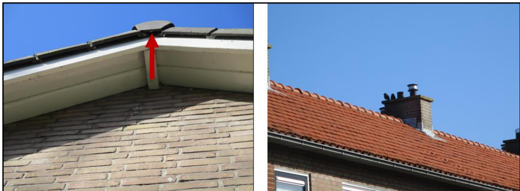
Figuur 2.23 Links: mogelijke openingen die gebruikt kunnen worden door gierzwaluwen en vleermuizen. Rechts: de dakruimte is toegankelijk voor huismussen.
