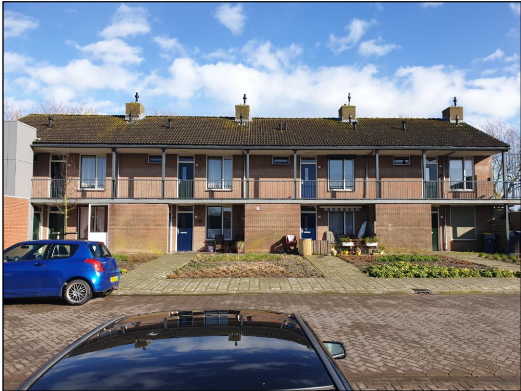
Figuur 2.10 Het wooncomplex betreft woningen bestaande uit drie bouwlagen.
