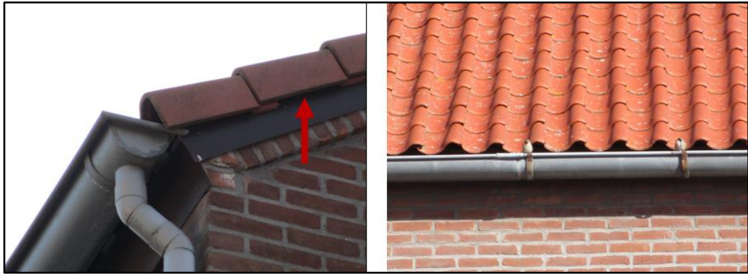
Figuur 2.47 Links: mogelijke openingen die gebruikt kunnen worden door gierzwaluwen en vleermuizen. Rechts: de dakruimte is toegankelijk voor huismussen.
