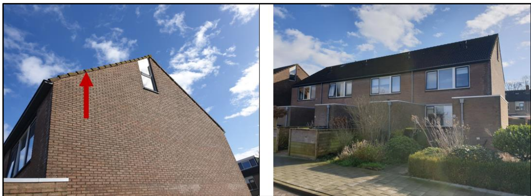
Figuur 2.11 Links: mogelijke openingen die gebruikt kunnen worden door gierzwaluwen en vleermuizen. Rechts: de dakruimte is toegankelijk voor huismussen.
