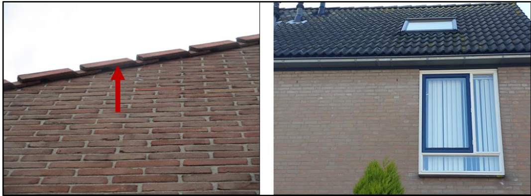
Figuur 2.14 Links: mogelijke openingen die gebruikt kunnen worden door gierzwaluwen en vleermuizen. Rechts: de dakruimte is toegankelijk voor huismussen.
