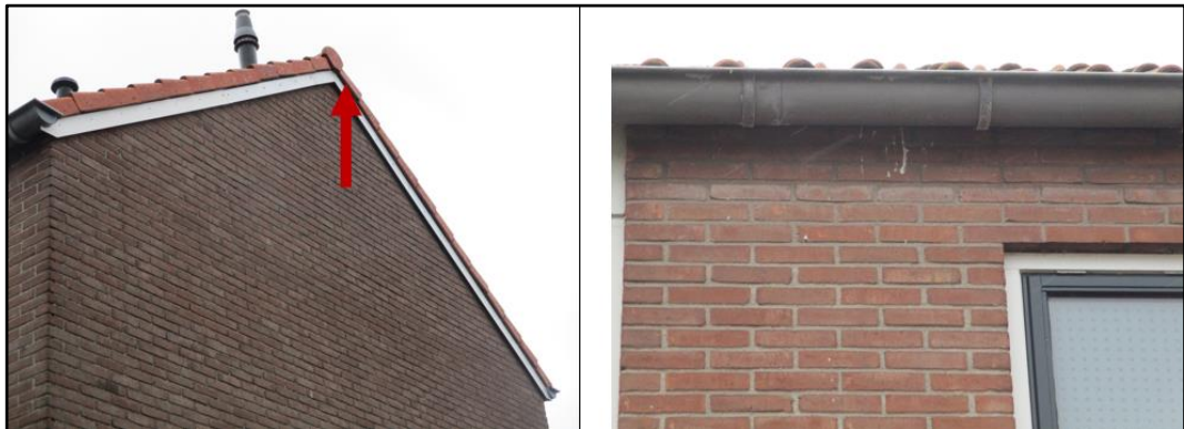
Figuur 2.41 Links: mogelijke openingen die gebruikt kunnen worden door gierzwaluwen en vleermuizen. Rechts: de dakruimte is toegankelijk voor huismussen.
