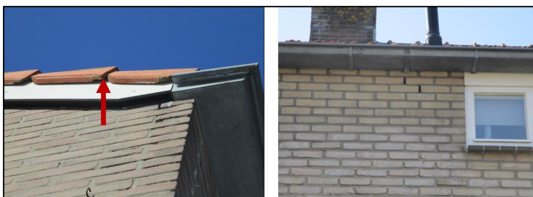
Figuur 2.17 Links: mogelijke openingen die gebruikt kunnen worden door gierzwaluwen en vleermuizen. Rechts: de dakruimte is toegankelijk voor huismussen.
