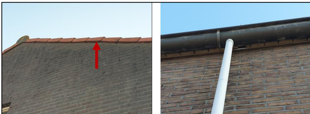
Figuur 2.53 Links: mogelijke openingen die gebruikt kunnen worden door gierzwaluwen en vleermuizen. Rechts: de dakruimte is toegankelijk voor huismussen.
