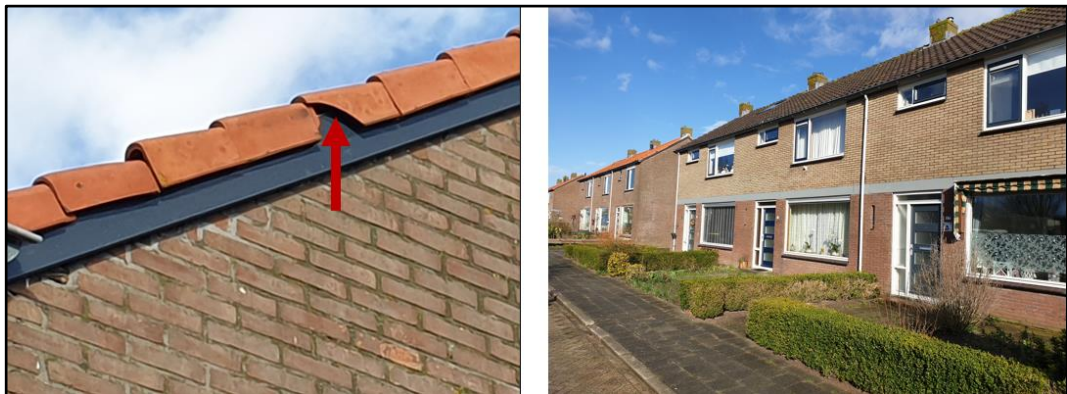
Figuur 2.8 Links: mogelijke openingen die gebruikt kunnen worden door gierzwaluwen en vleermuizen. Rechts: de dakruimte is toegankelijk voor huismussen.
