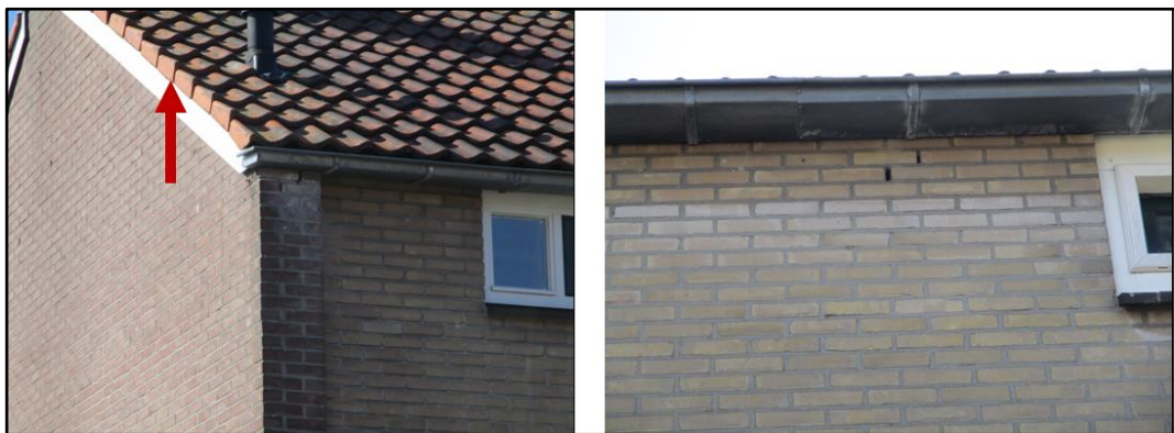
Figuur 2.20 Links: mogelijke openingen die gebruikt kunnen worden door gierzwaluwen en vleermuizen. Rechts: de dakruimte is toegankelijk voor huismussen.
