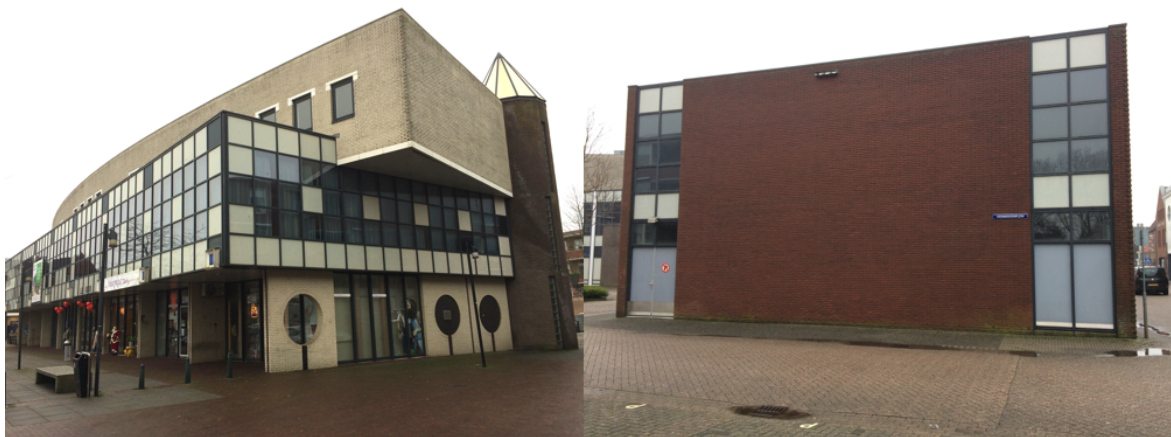
Afbeelding 6 en 7. De voorzijde (gezien vanaf Vierwiekenplein) en achterzijde van het kantoorgebouw
