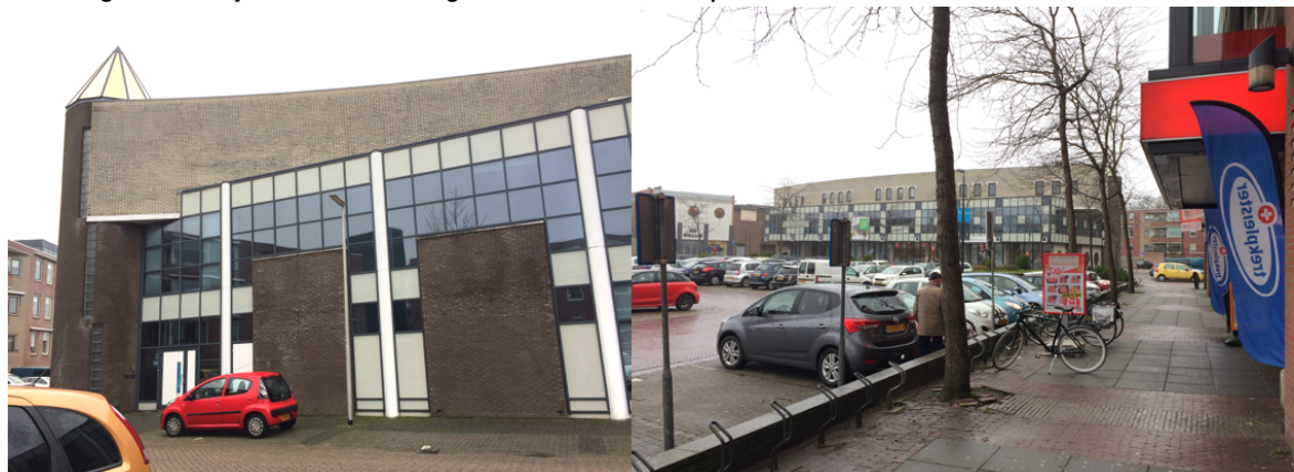
Afbeelding 8 en 9. De zijkant van het kantoorgebouw en het Vierwiekenplein
