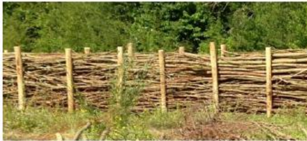
Takkenril bij aanleg
