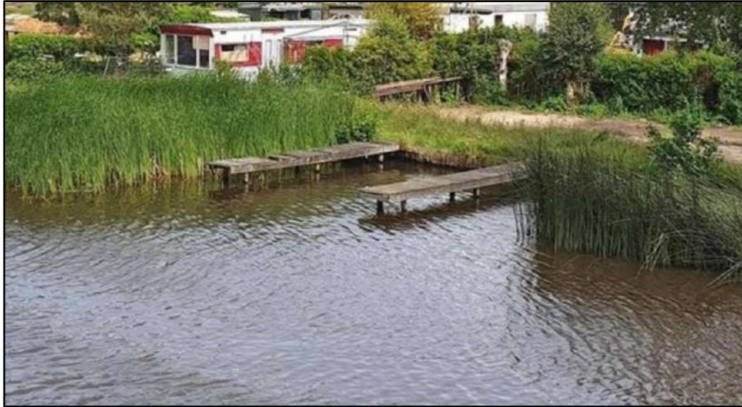
Figuur 3.5 Voorbeeld van een aanlegsteiger met riet en rietgras. De oever betreft hier geen natuurvriendelijke oever , aangezien deze een harde beschoeiing heeft.
