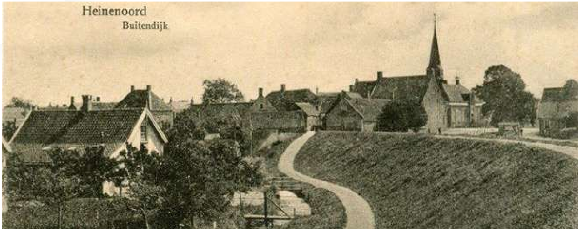
Sprong over de dijk, goed zichtbaar vanaf de Buitendijk.
