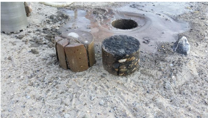
foto 5: asfaltboring 8, deellocatie A
