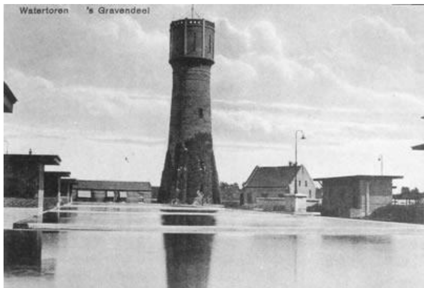
Afb.12. De in 1913-1915 in het plangebied gerealiseerde watertoren.
