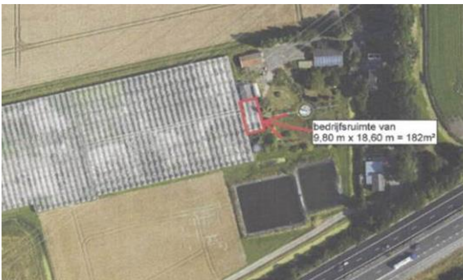
Figuur 2.4 foto bebouwing Westdijk 51 Mijsheerenland
