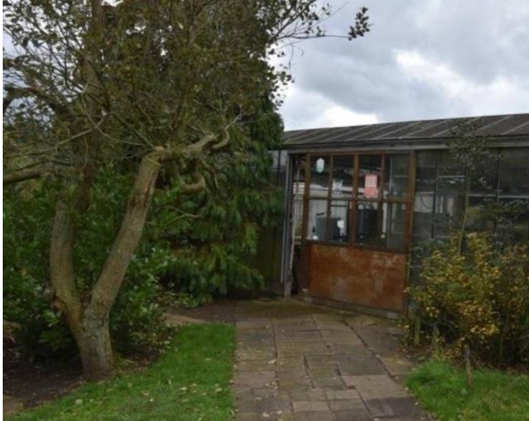
Figuur 2.5 foto af te breken bedrijfsbebouwing Westdijk 51
