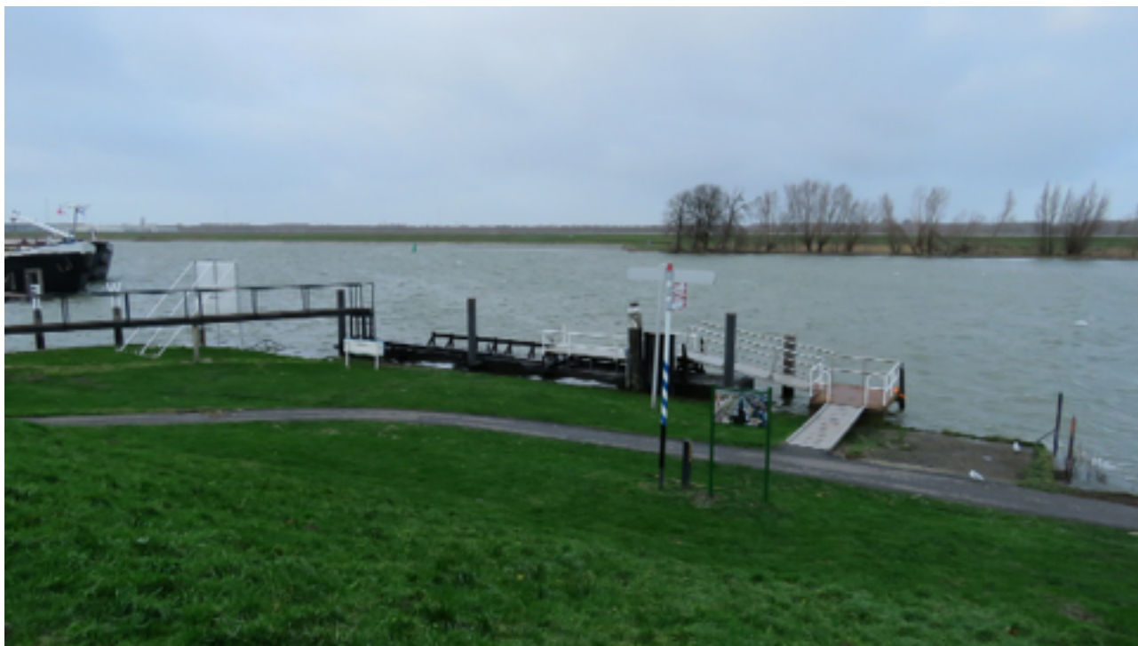
Afb.3: De te verwijderen aanlegsteiger.
