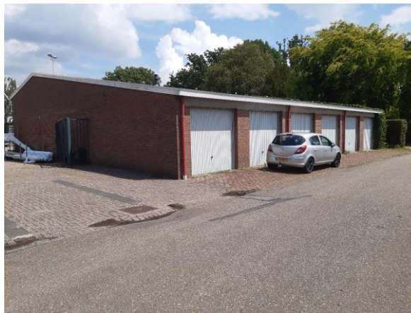
Foto 2: Voorzijde garageboxen met in dezelfde bebouwing de achterliggende werkplaats, vanaf de Prins Bernhardlaan.
