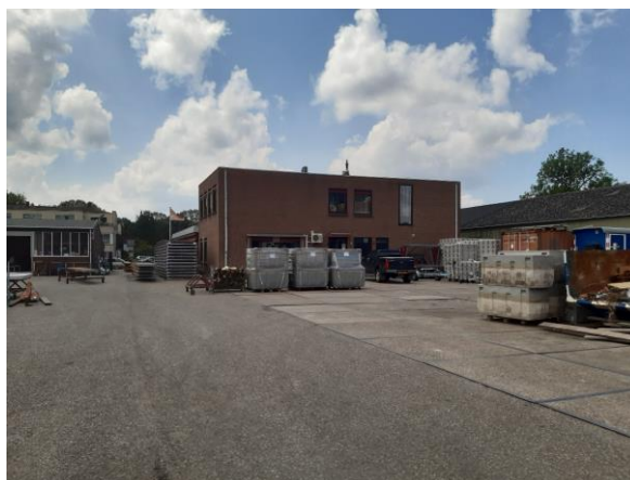
Foto 4: Buitenterrein verhard met betonplaten (stelcon) en asfalt met op de achtergrond de ingang van de locatie vanaf de Prins Bernhardlaan en de achteringang van het kantoorpand.
