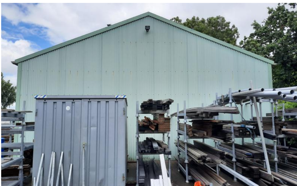
De loods met bouwjaar 1997. Deze is vanwege de bouwstijl ongeschikt voor verblijfplaatsen van vleermuizen. Foto: M.M. Bouwmeester | Ecoresult B.V.
