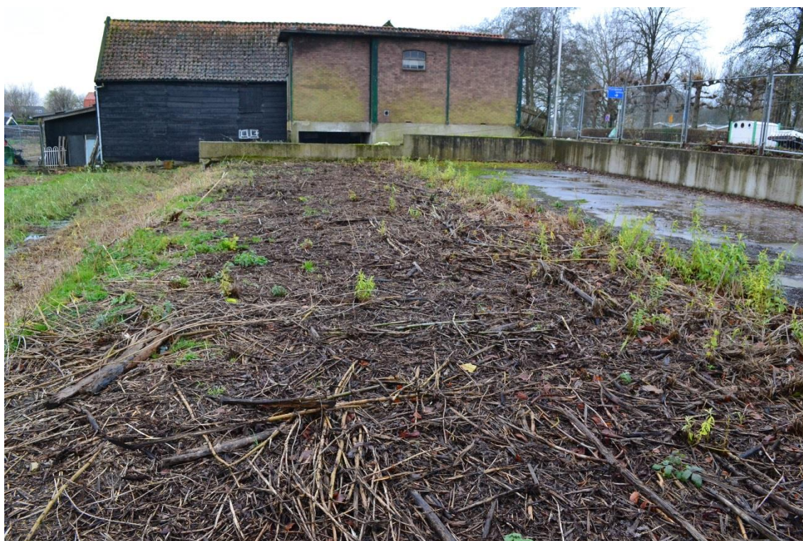
Figuur 14. Braakliggend terrein waar in het voorjaar riet en wilg op komen zetten.
