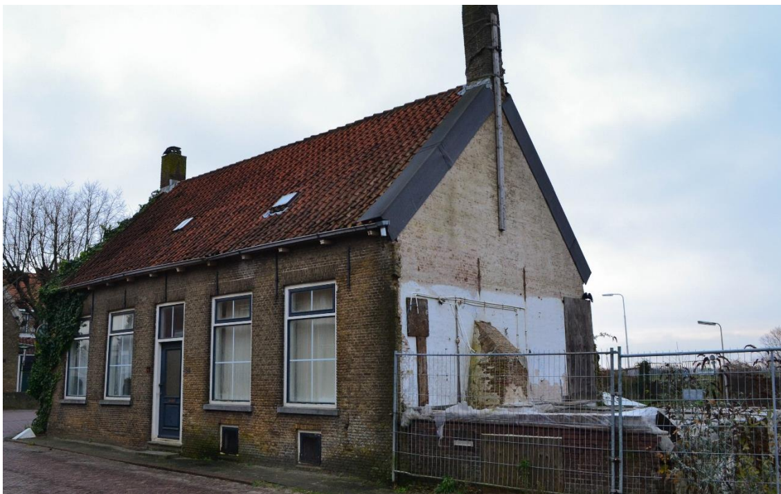
Figuur 3. Voorkant woning aan de Schouteneinde 64, Puttershoek.
