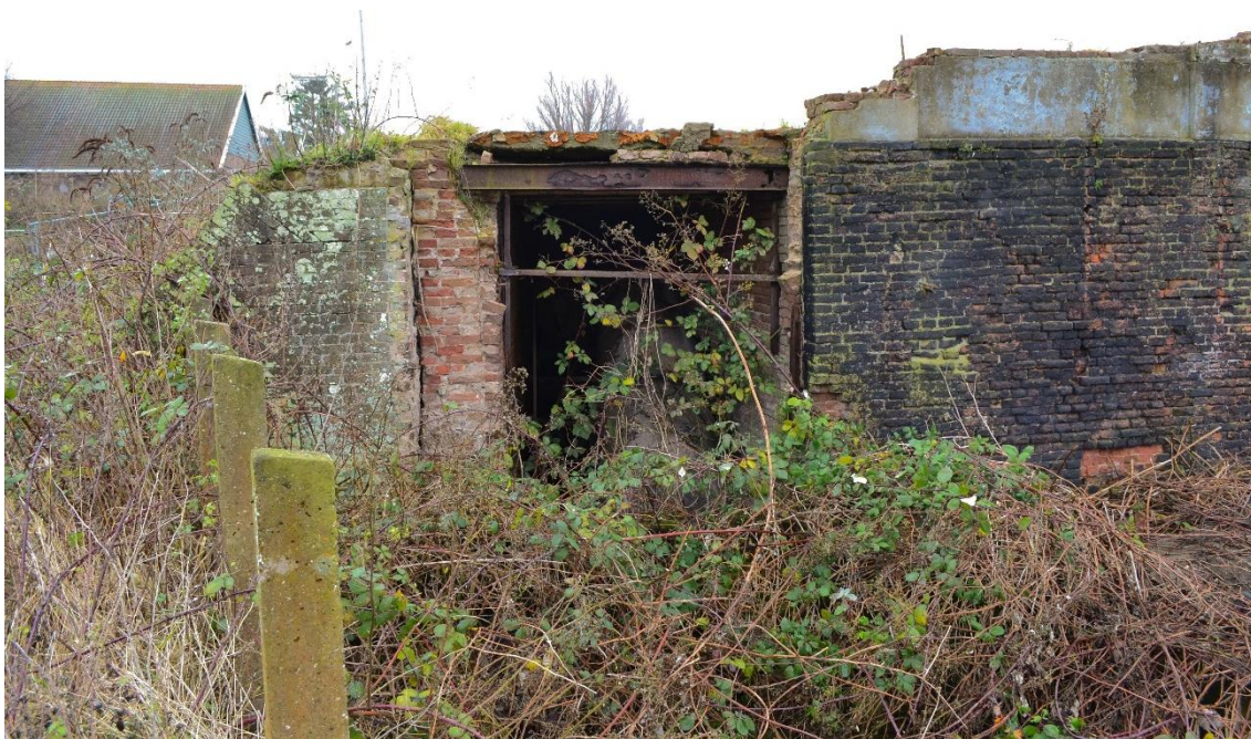
Figuur 15. Open ruimte van een oude al eerder afgebroken woning. Vermoedelijk is dit een kelder of schuur geweest.
