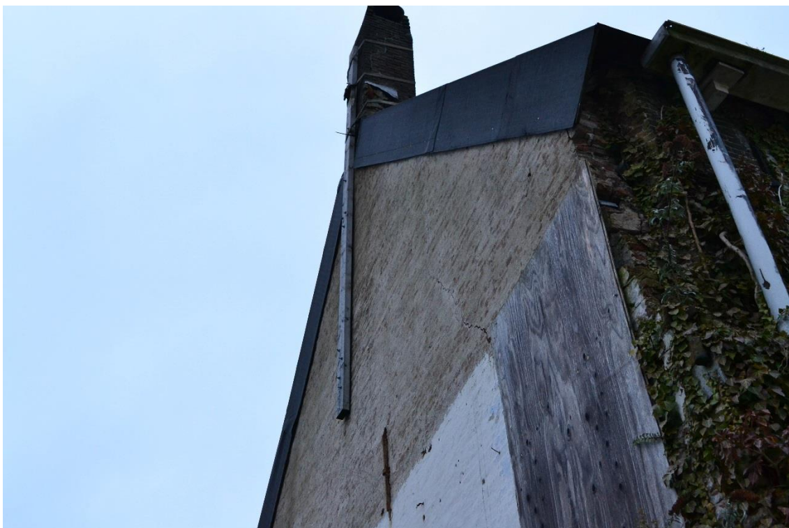
Figuur 8. De kopse kant van de woning is volledig afgedekt en niet toegankelijk voor dieren.
