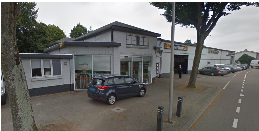
Figuur 2.2: foto huidige bebouwing vanuit zuidwestelijke richting Oostdijk
