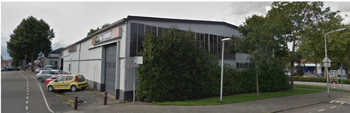
Figuur 2.1: foto huidige bebouwing vanuit zuidoostelijke richting Oostdijk
