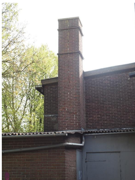
Figuur 6. De schoorsteen vormt een potentiële verblijfplaats voor vleermuizen.
