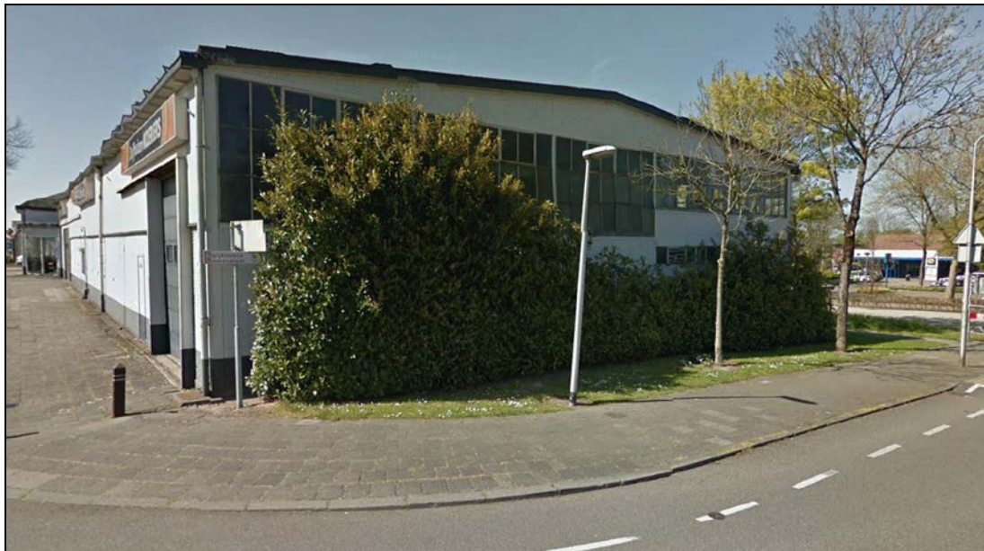
Afbeelding 17. De bebouwing ter plaatse van het oostelijke deel van het plangebied in 2016. Bron: GoogleEarth.
