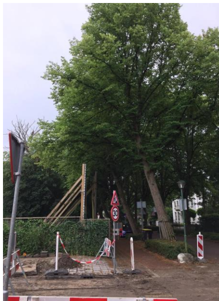
Figuur 3. Aan beide zijden van de Raadhuislaan staat een bomenrij met links in beeld het bouwterrein.
