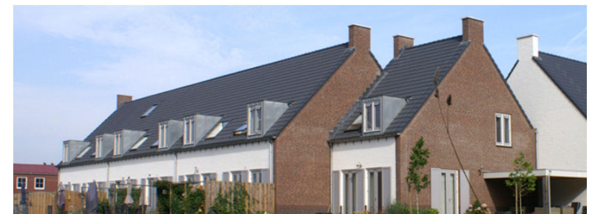
Verspringing binnen het bouwvolume en karakteristieke schoorstenen.
