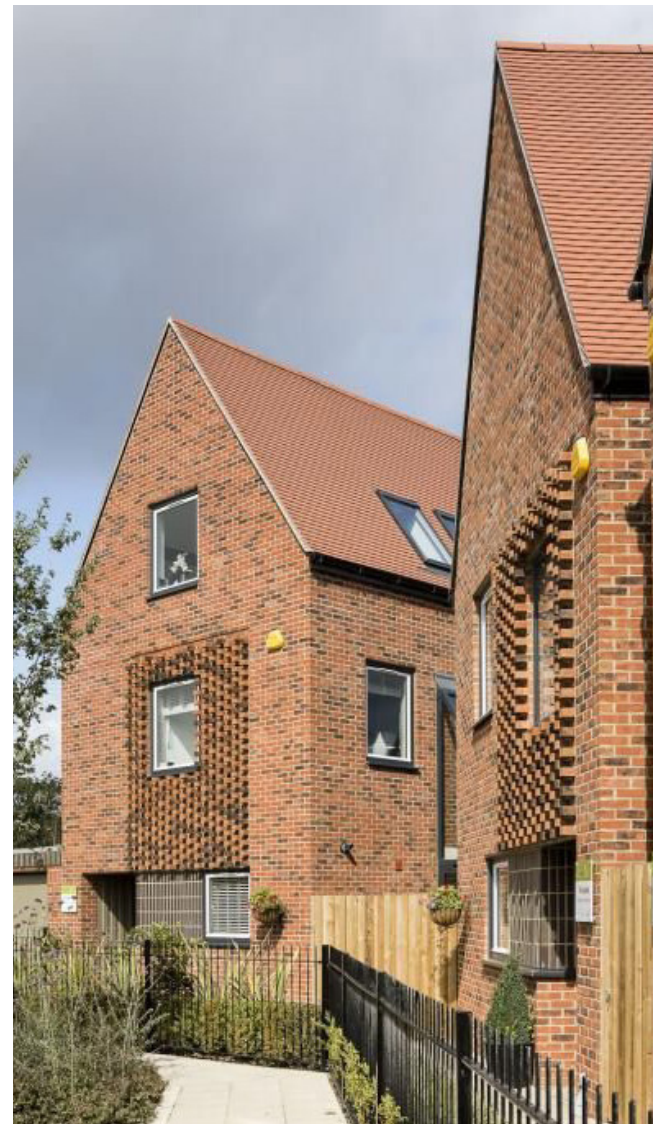
Kopgevels met gevelopeningen georiënteerd richting de openbare ruimte.
