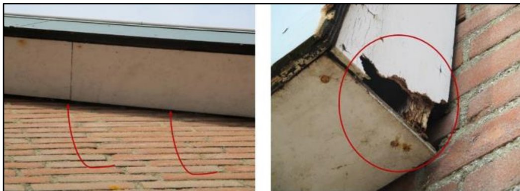
Figuur 1.3 Middels openingen in de boeiboorden en tussen gevel en boeiboord kunnen vleermuizen toegang krijgen tot potentiële verblijfplaatsen in de bebouwing.
