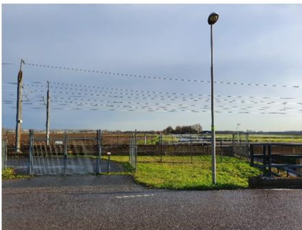
Fig. 3: de verdiepte weg onder het spoor
