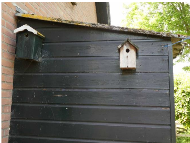
Figuur 10: Kleine schuur aan de achterzijde van de woning
