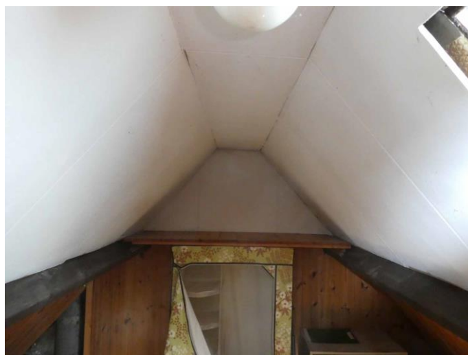
Figuur 15: Afwerking van het dak aan de binnenkant van de woning
