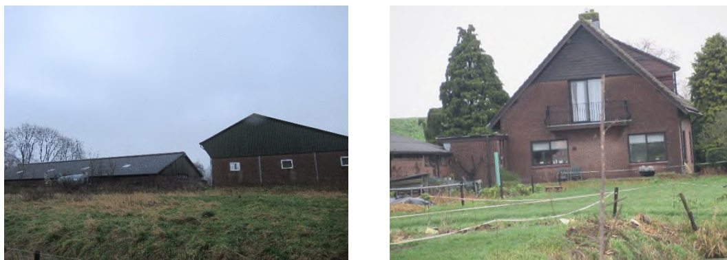
Figuur 4.3. Voorbeelden van gebouwen die mogelijk geschikt zijn als verblijfplaats voor vleermuizen.
