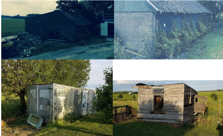
Afbeelding 20: Te slopen schuren (Kanaaldijk 17a)
