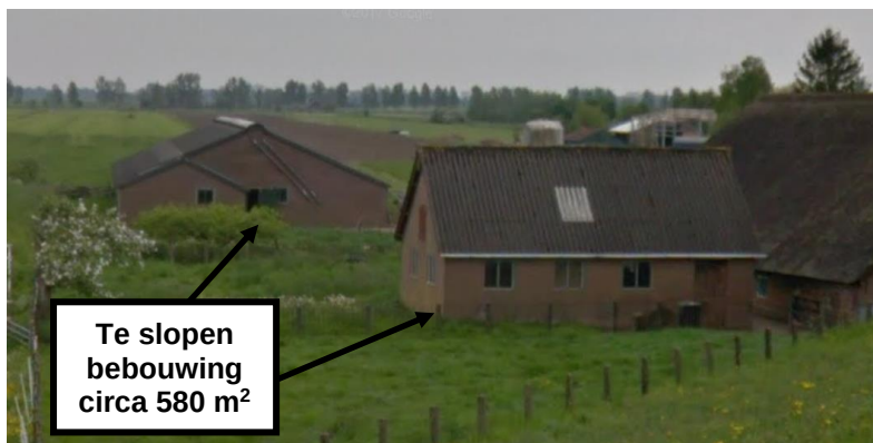
Afbeelding 21: Te slopen bebouwing (Lekdijk 29 Tienhoven a/d Lek)
