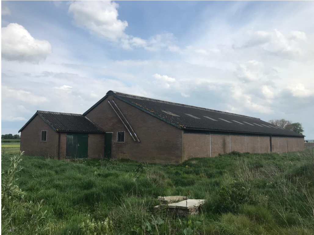
Figuur 3 De te slopen stal aan de Lekdijk 29 te Tienhoven aan de Lek.
