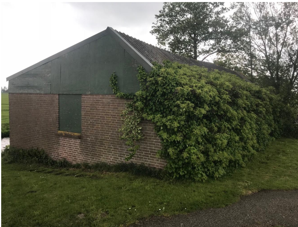
Figuur 1 De te slopen schuur aan de Kanaaldijk 16 te Hei- en Boeicop
