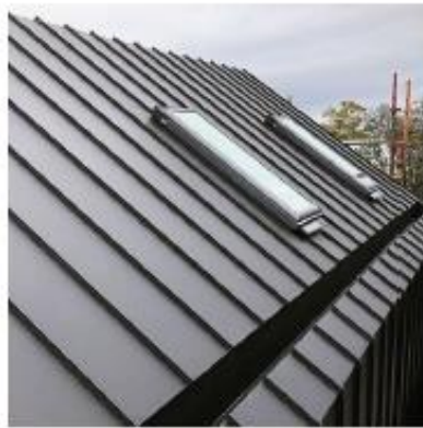
Dak bekleding Zwart staal
