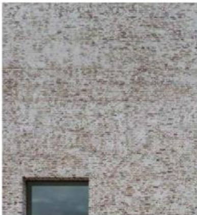
Gevel bekleding Licht metselwerk
