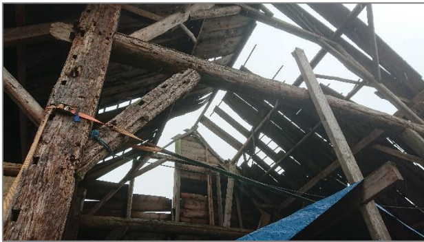
Afbeelding 1.5 | Dakconstructie grote schuur.
