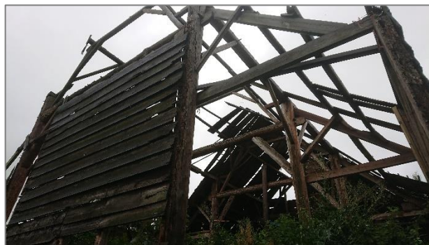
Afbeelding 1.4 | Dakconstructie grote schuur.
