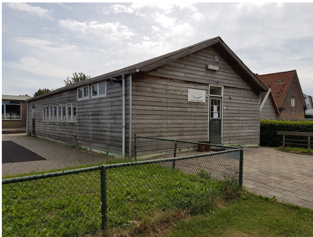
Figuur 2 Het pand van H.S.V. Ameide aan de Doelakkerweg 63 te Ameide wordt gesloopt. De ruimte zal heringericht worden als schoolplein.
