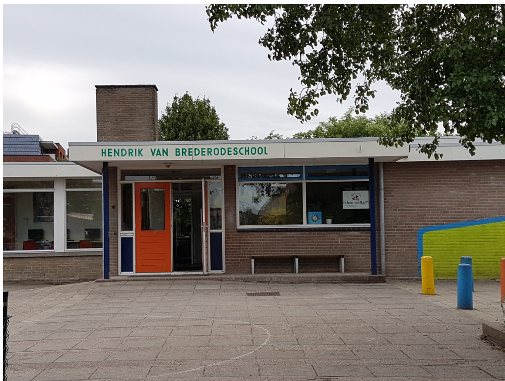
Figuur 1 De planlocatie is gelegen aan Liesveldweg 65 te Ameide. Het schoolgebouw van de Hendrik van Brederodeschool wordt gesloopt ten bate van de realisatie van een nieuw schoolgebouw.
