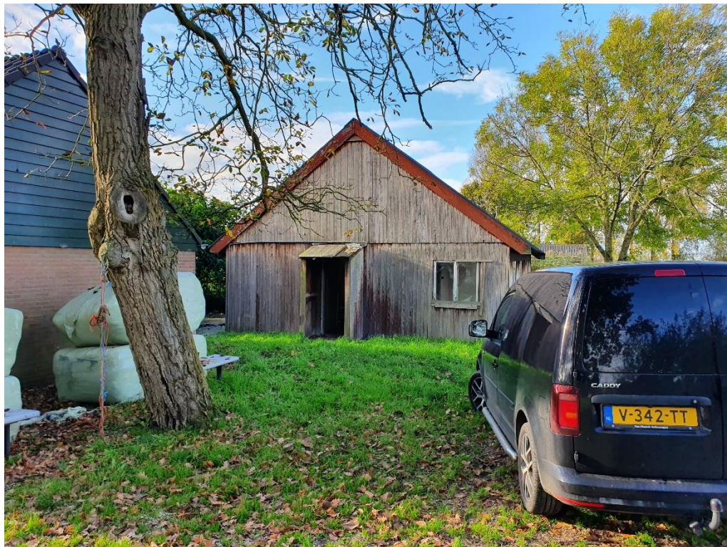
Figuur 2 De schuur op de planlocatie opgetrokken uit houten wanden met een golfplaten zadeldak zonder dakbeschot.
