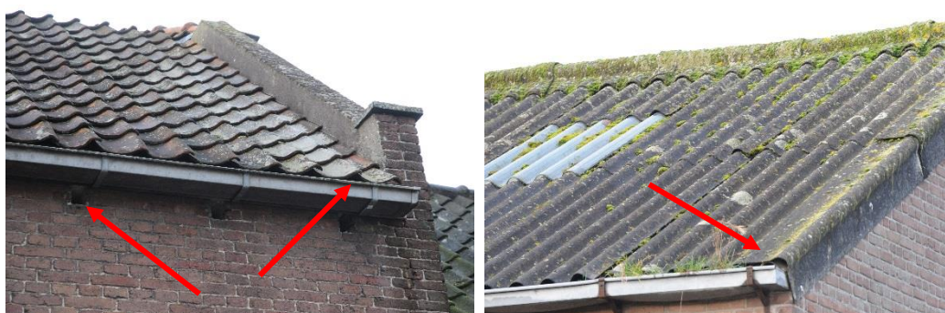
Openingen die potentieel toegang bieden voor vleermuizen. (Foto Laneco).
