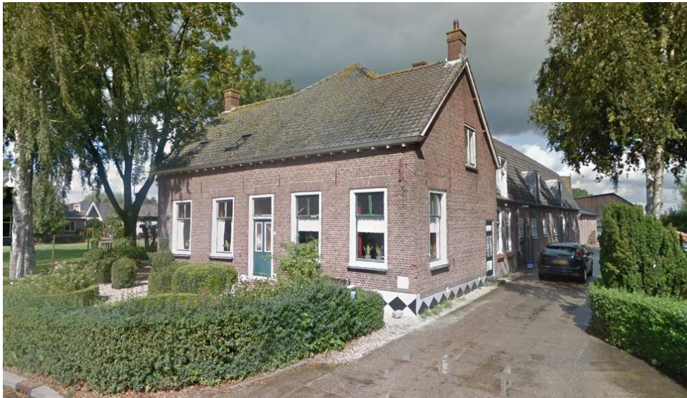
Afbeelding 4: Vooraanzicht op de twee bedrijfswoningen vanaf het Recht van ter Leede
