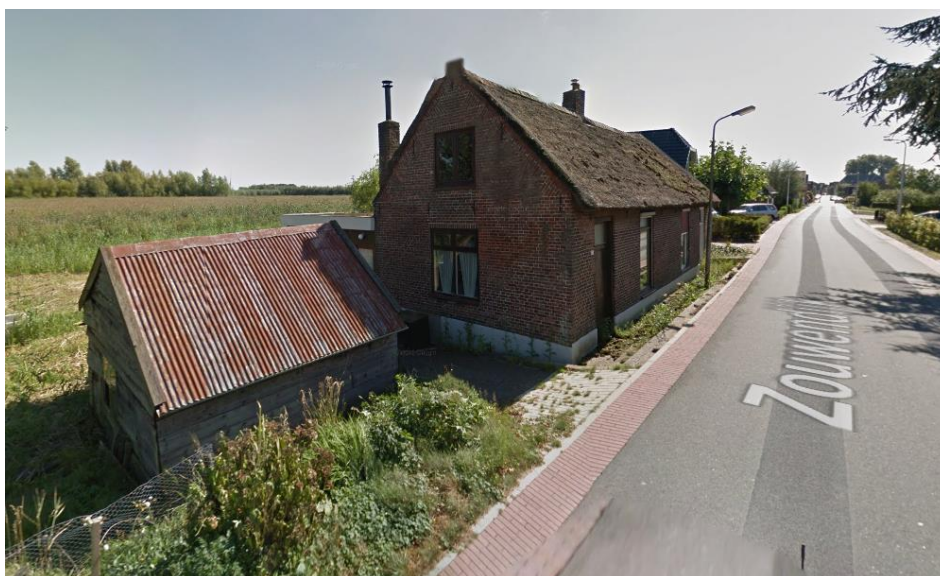
Afbeelding 8: Aanzicht bestaande bebouwing deelgebied 1 (Zouwendijk 68-70)
