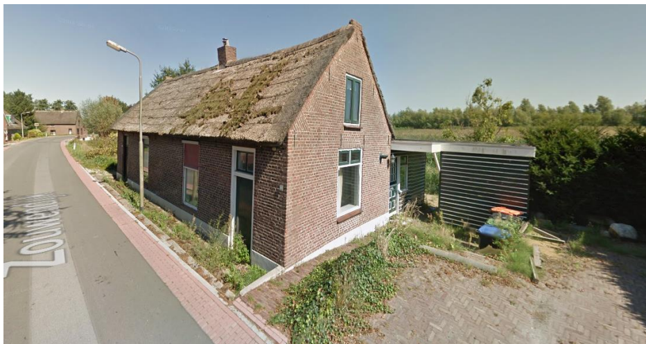
Afbeelding 7: Aanzicht bestaande bebouwing deelgebied 1 (Zouwendijk 68-70)
