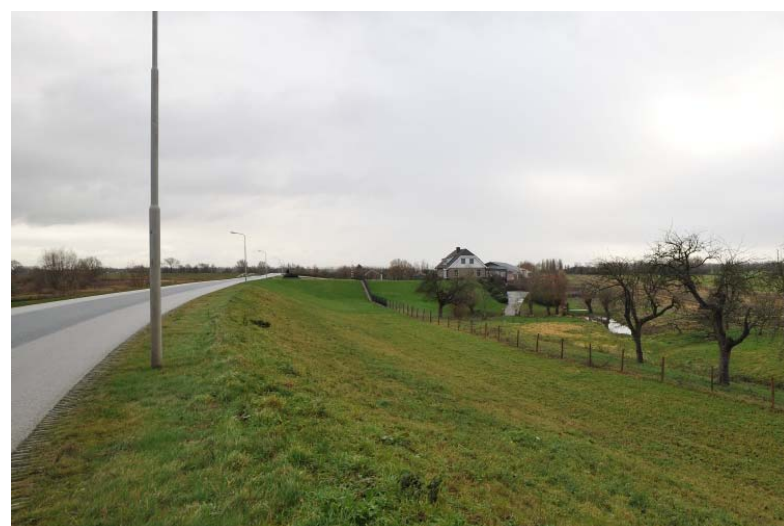
Zicht op projectgebied vanaf Lekdijk in zuidelijke richting
