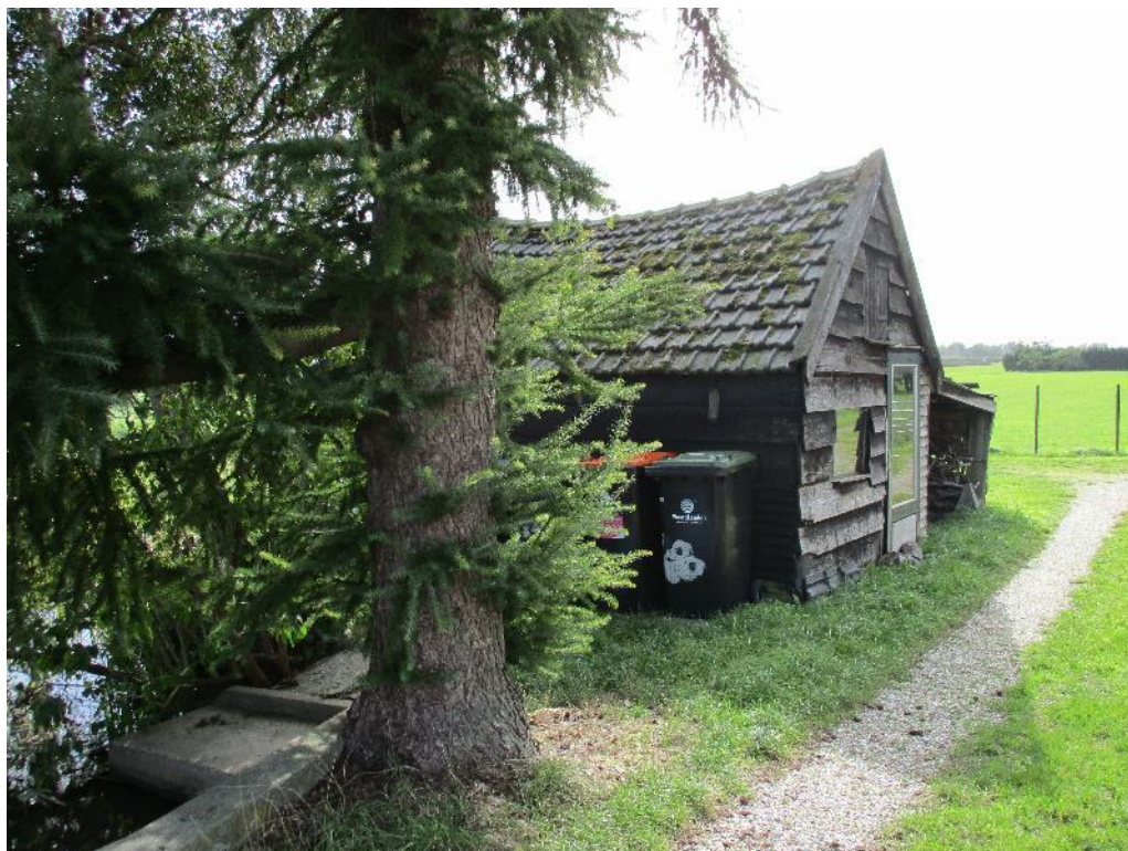
Figuur 2 De schuur is opgetrokken uit houten panelen en deels een zadeldak met dakpannen en deels een golfplaten dak.
