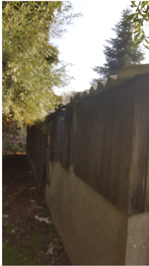
achterzijde van schuur 1, asbest-gootlijn
